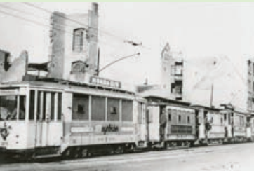
Fast unbeschädigt führen die abgebildeten Züge 1946 wieder über den zerstörten Steinweg
