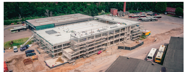
2018: Beginn der Grunderneuerung des Busbetriebshofes
