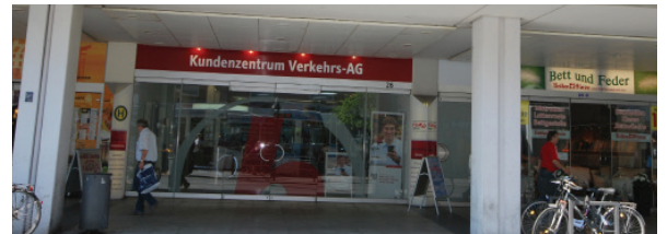
2011: das neue Kundenzentrum an der Haltestelle Rathaus
