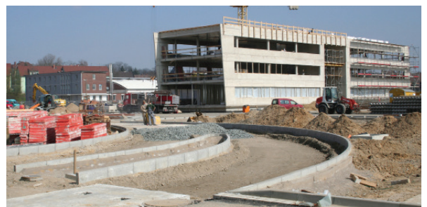
Baustelle des neuen Tramdepots im Jahr 2008
